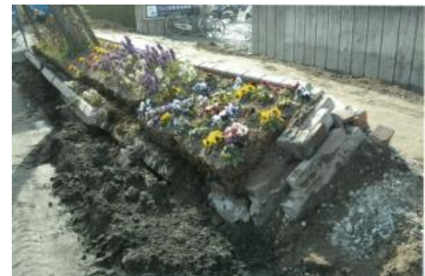
図 1 液状化被害の写真 倒壊した花壇
